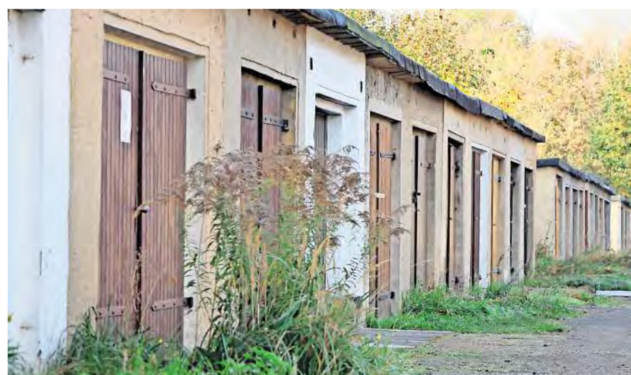
Der Garagenhof in Lobstädt wird komplett privatisiert.
