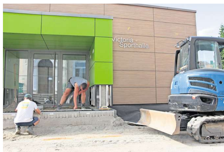
Noch ist die Halle leer, doch am 27. August steppt in der Victoria-Sporthalle in Lobstädt der Bär. Foto: André Neumann
