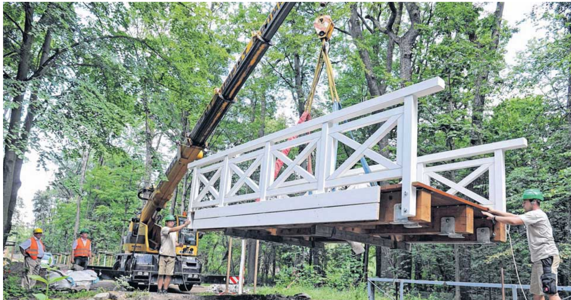
Gestern im Schlosspark Röttha: Die neue Brücke traf mit etwas Verspätung, aber pannenfrei ein. In den kommenden Tagen wird sie montiert. Wenn die Wege angepasst wurden, kann die Spezialkonstruktion genutzt werden. Fotos: Thomas Kube
