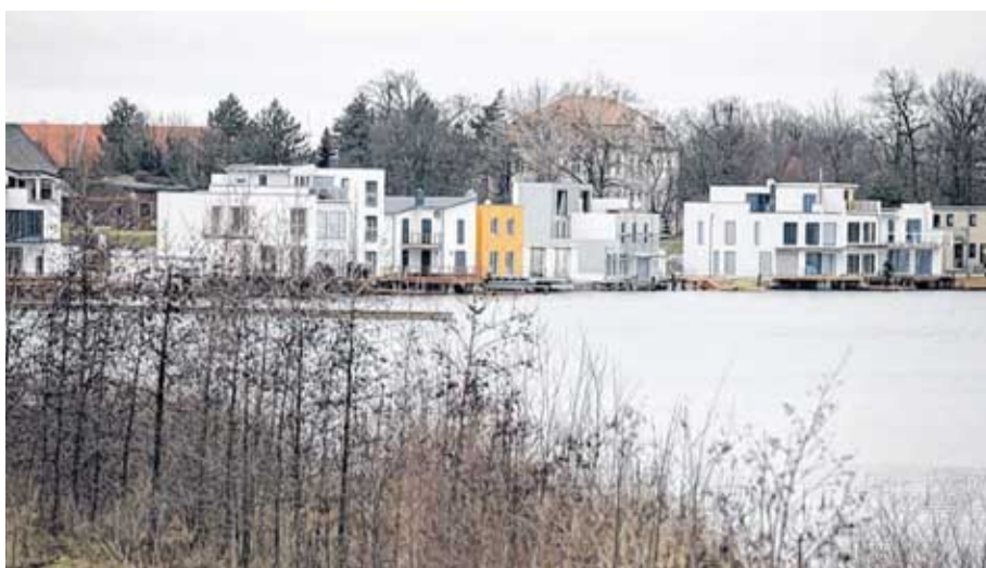
In der Feriensiedlung Lagune Kahnsdorf liegt jetzt ein leistungsfähiges Breitband-DSL an, das für schnelle Internetzugänge sorgt. Fotos: Jakob Richter
