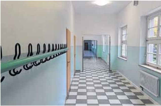
Hell und freundlich: Die Sanierung des Südflügels der Oberschule Böhlen ist weitestgehend abgeschlossen.
