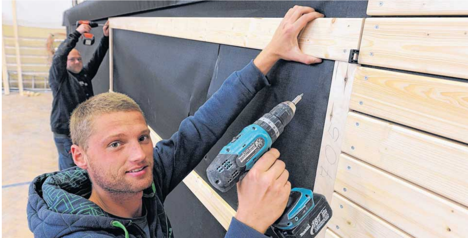
Marcus Uebel (vorn) von der Holzbaufirma Hertel aus Gera und Uwe Braunert von SPOMA Parkett und Ausbau GmbH aus Hermsdorf montieren die neuen Prallschutzwände in der Sporthalle der Oberschule Böhlen. Fotos: Thomas Kube
