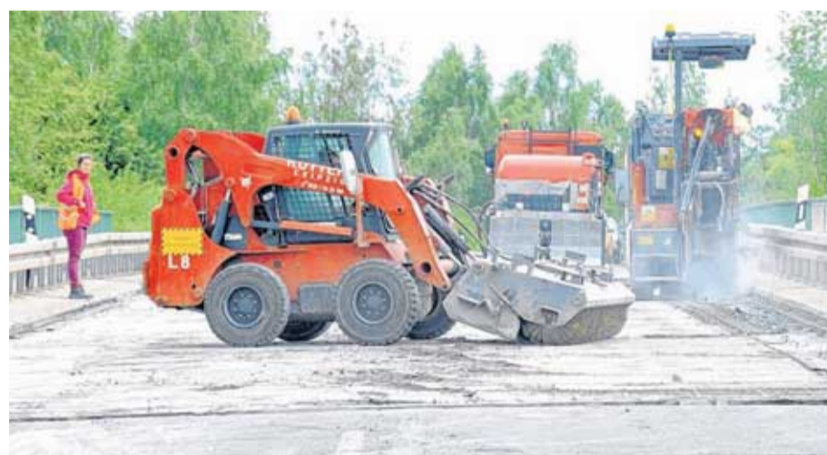
Die Brücke über die Bahntrasse in Neukieritzsch wird derzeit saniert – und sorgt für eine Vollsperrung der B 176 bis zum Ende der Sommerferien. Foto: Thomas Kube
