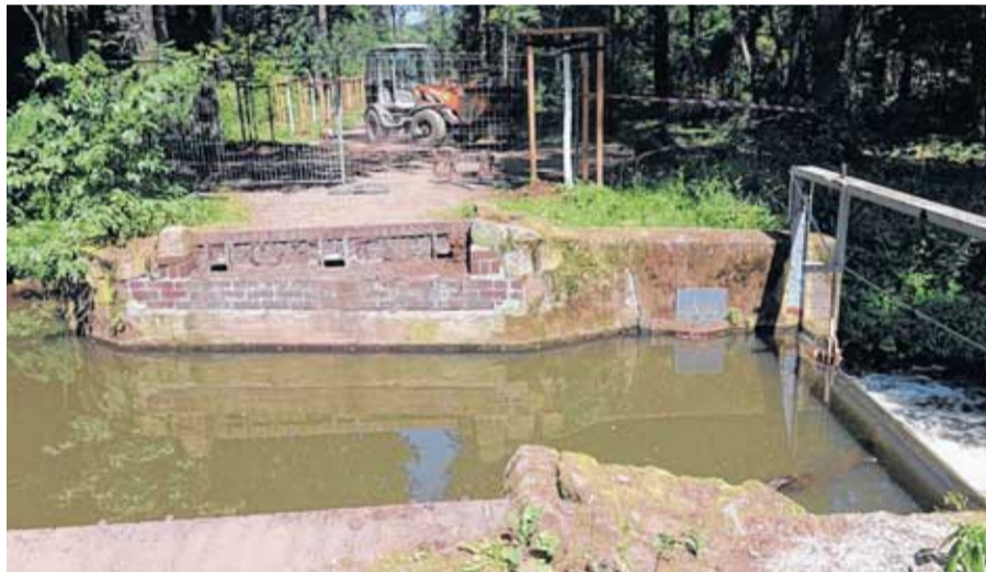
Die Brücke im Schlosspark Rötha wurde gestern Morgen per Kran abgehoben. Sie wird durch eine neue ersetzt. Der Weg ist zwangsläufig gesperrt. Foto: Thomas Kube
